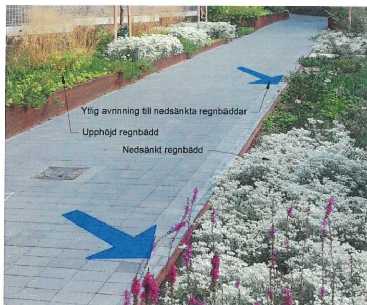
Figur 19 Illustration över en kombination av upphöjda respektive nedsänkta regnbäddar med yttlig avrinning från hårdgjord mark till nedsänkta grönytor
