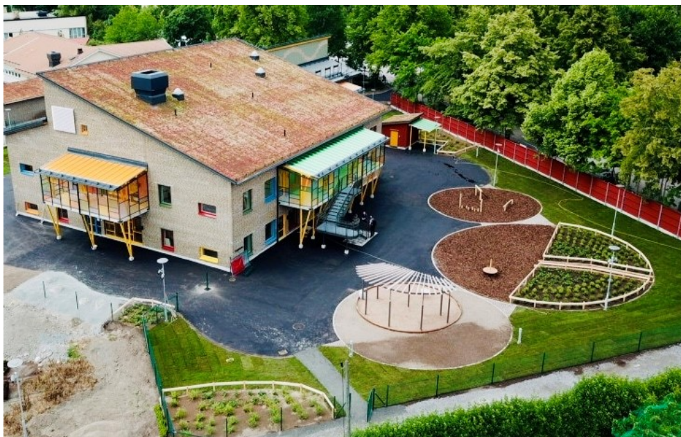
Grillby förskola. Typförskola byggd 2021.
