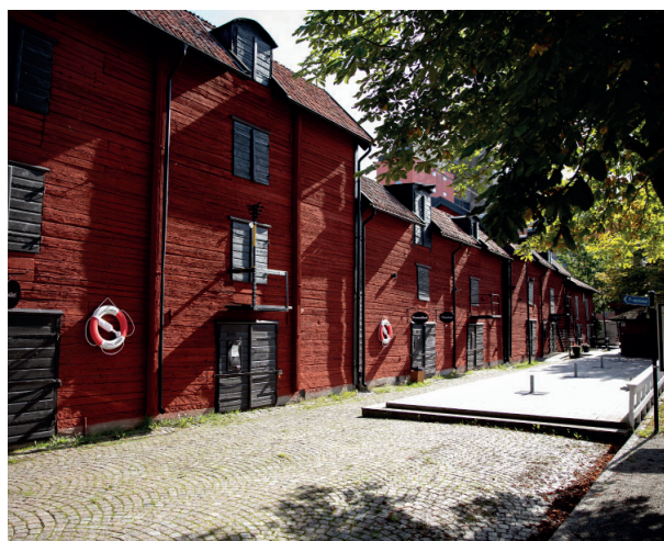
Hamnmagasinen. Foto: Enköpings kommun.
