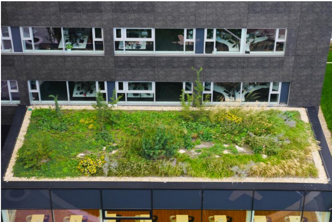
Figur 3. Exempel på utformning av tjockt grönt tak. Foto: Jonathan Malmberg.
