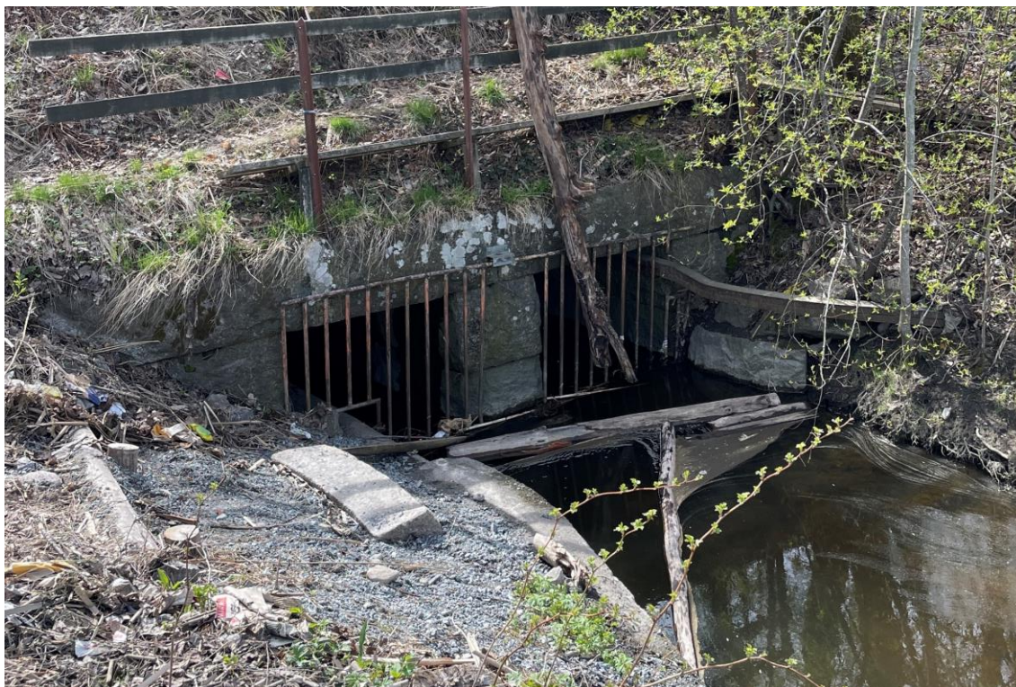
Figur 9. En kulvert med två parallella tunnlar löper under järnvägen i planområdets sydöstra del. Foto: WRS 2024.
