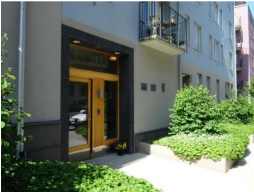
Figur 1. Exempel på regnbäddar för takvatten placerade på förgårdsmark i Stockholm. Foto: WRS.
