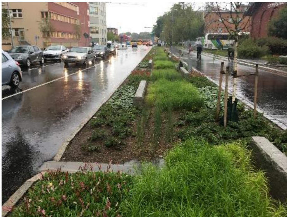
Figur 23. Exempel på utformning av nedsänkta regnbäddar med trädplantering i anslutning till gata, gång- och cykelväg i Uppsala. Foto: WRS.
