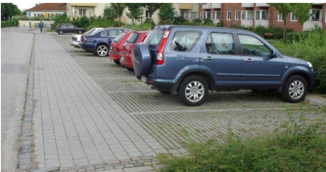
Figur 8. Exempel på parkering med genomsläpplig beläggning. Foto WRS.
