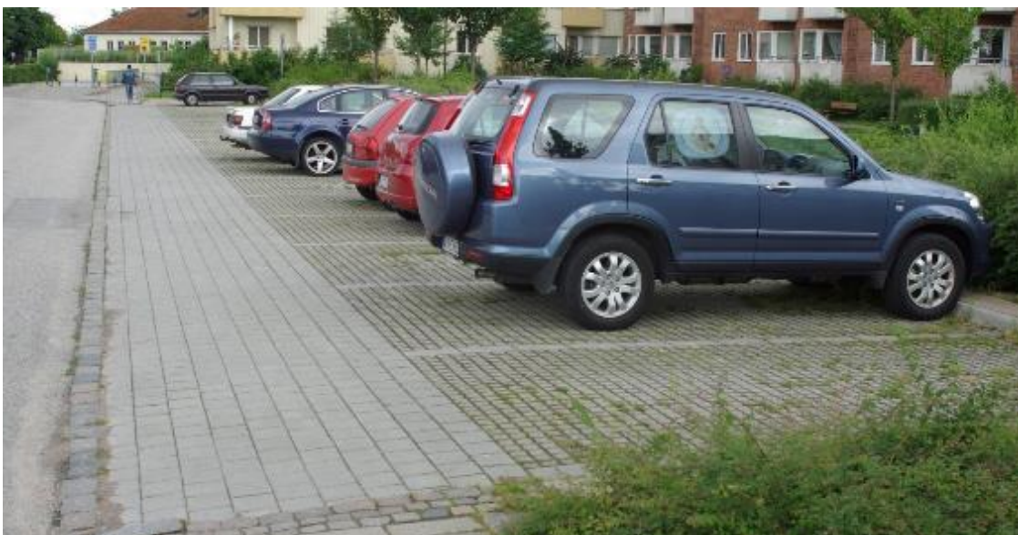
Figur 26. Exempel på parkering med genomsläpplig beläggning. Foto WRS.
