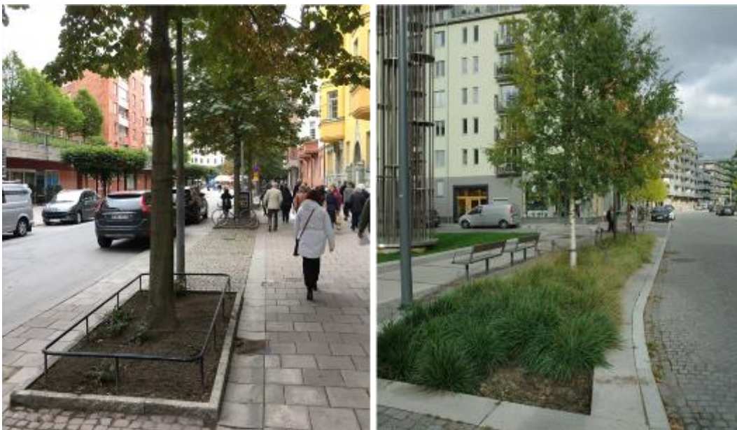
Figur 25. Två exempel på träd i skelettjordar. Eftersom konstruktionen ligger under markytan kan anläggningen anpassas gestaltningsmässigt för att passa in i området. Foto: WRS.
