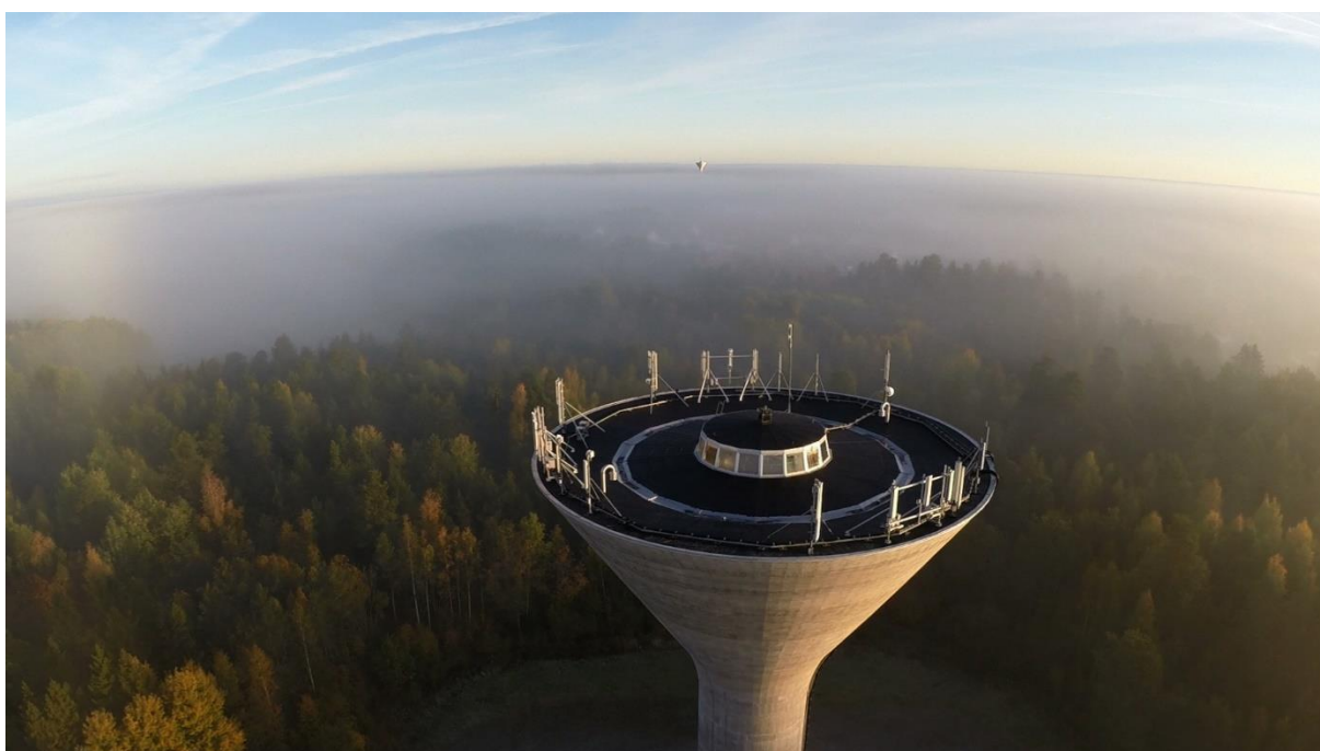
Bild på Enköpings vattentorn.
