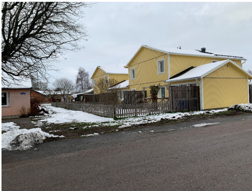
Figur 12. Vy från Skolvägen. Fotot visar befintlig bebyggelse inom del av Rymningen 8:100.
