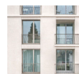
Färska fönster i kombination med balkonger, Brechtbauer Wälder Architekten
