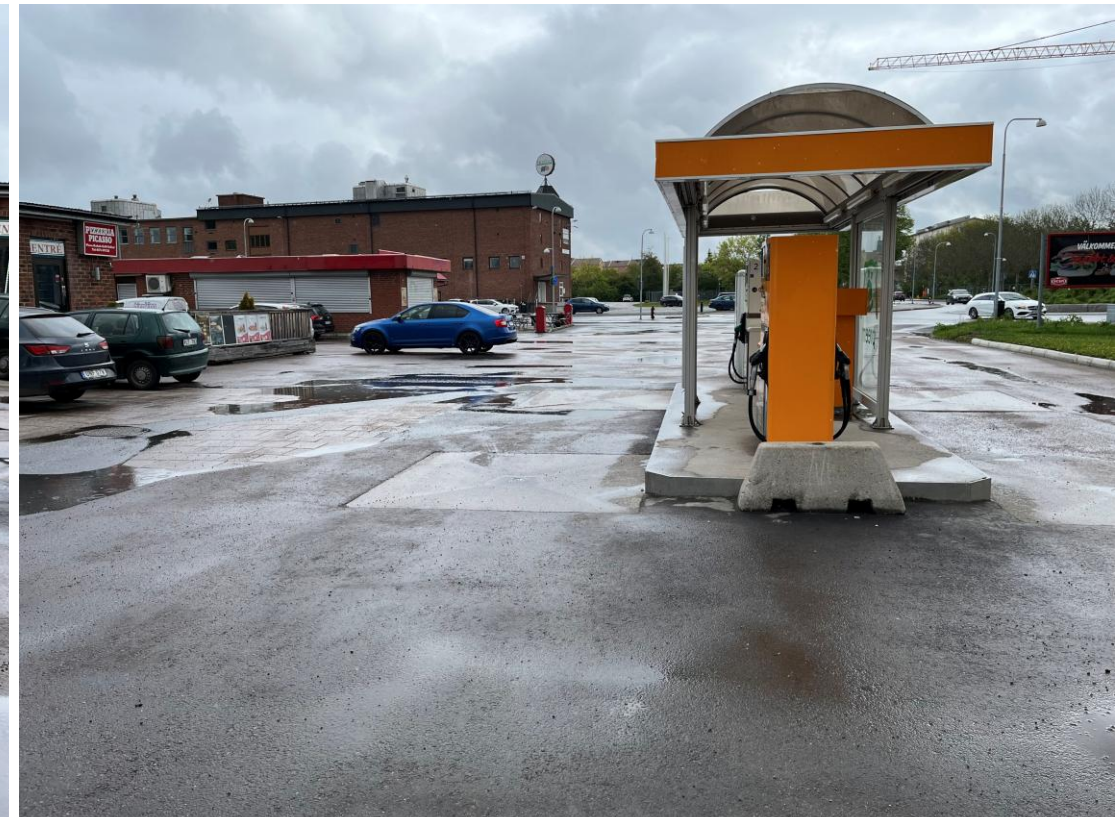
Pumpö med tillhörande spillplattor, kopplade till separat oljeavskiljare öster om ön.
