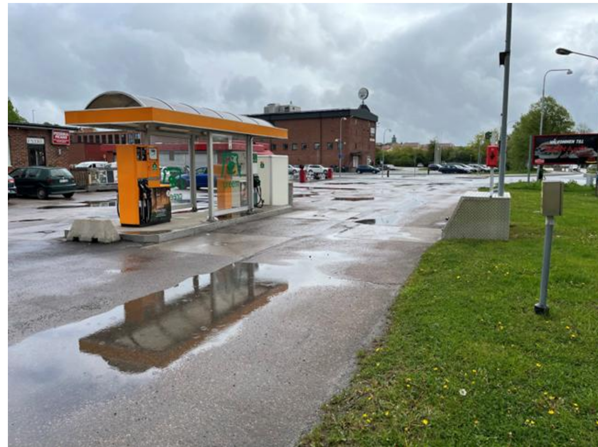
Centralpåfyllning med tillhörande spillplatta, till höger.
