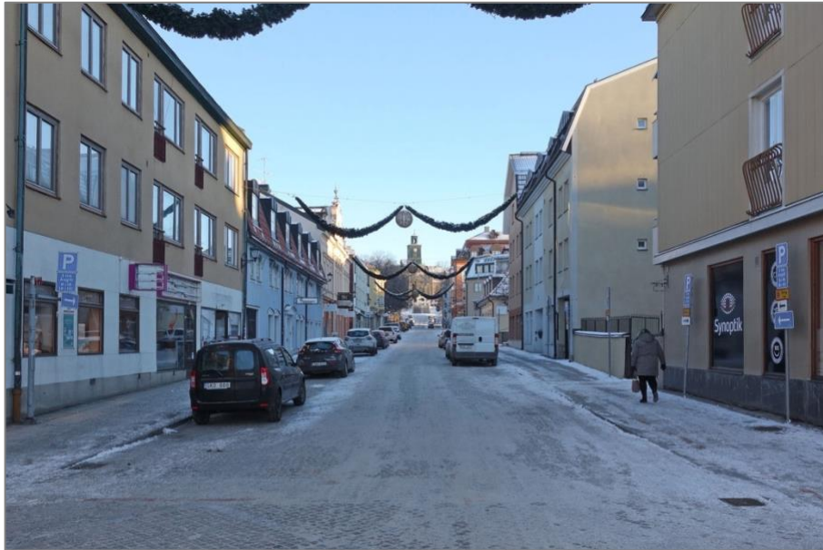
Kungsgatan sedd norrut från Torggatan med Vårfrukyrkan i fonden. Här syns den rika variation av byggnader som är rutnätsplanens signum. Genom konsekvent strikta kvarter, den ursprungliga tomtindelningen och husen i liv med gatan skapas ett sammanhang trots stora skillnader i ålder, arkitektur, material, höjder och färgsättningar.
