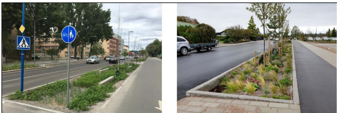
Figur 5-4. Infiltrationsstråk nära trafikbärande ytor.
