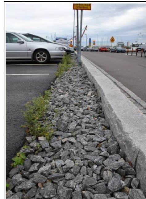
Figur 5-5. Exempel på utformning av infiltrationsytor, infiltrationsstråk nära parkering, tillsammans med gräsarmering.
