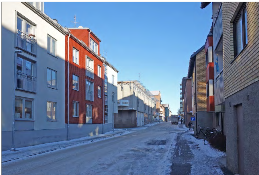
Eriksgatan sedd från söder med kvarteret Kopparslagaren till vänster och bostäderna i Kryddgården inom kvarteret Gelbgjutaren till höger. I bildens mitt syns Paushuset. Notera den långa siktlinje längs gatan som rutnätets plan möjliggör.
