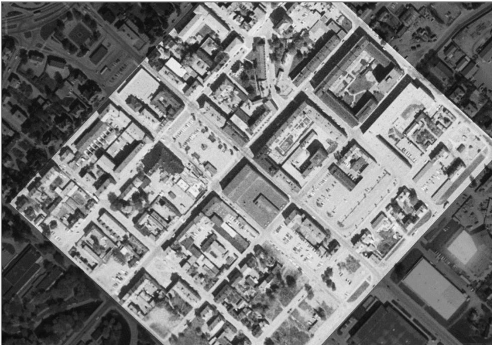
Bilden visar Enköpings centrum omkring 1975. Omfattande rivningar har genomförts och flera kvarter har tagits i anspråk för flerbostadshus, i vissa fall med kringbyggda gårdar. Andra används som parkeringsytor. Foton från www.lantmateriet.se 2021-02-26.
