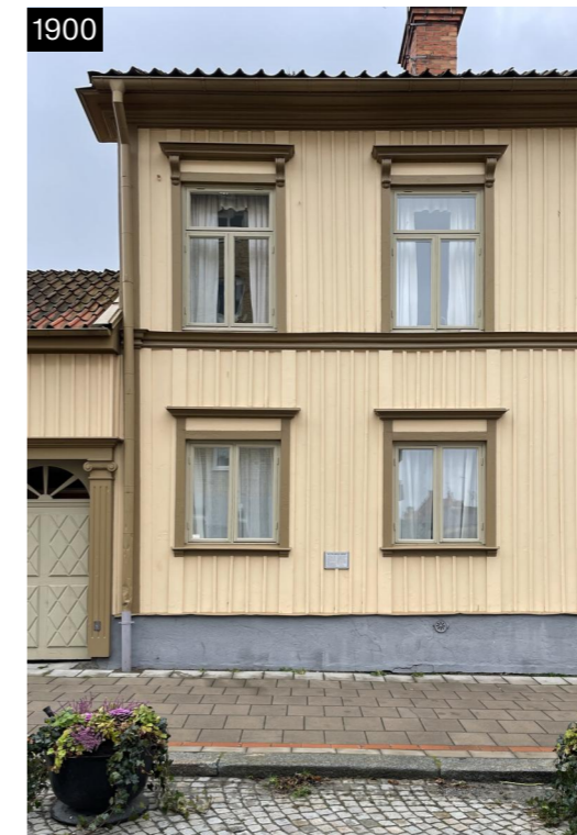
1900 Westerlundskas gården. Artikulerade fönsteromfattningar.
