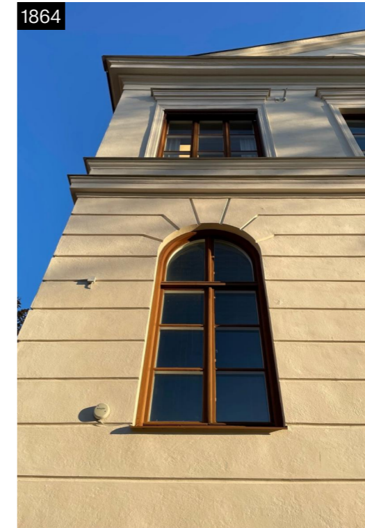
1864 Kulturskolan. Ljus putsfasad. Resliga fönster med mittpost.
