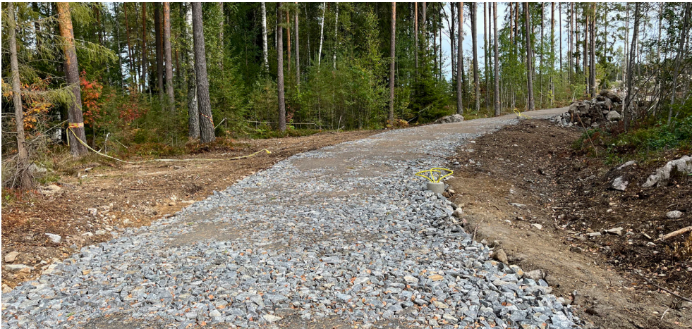
Bild på färdiglagd överbyggnad för GC-väg i Storskogen. Vid återplantering slänterna om ca 2-3 m på ömse sidor vägen nyttjas för återplantering av busk- och trädplantor.
