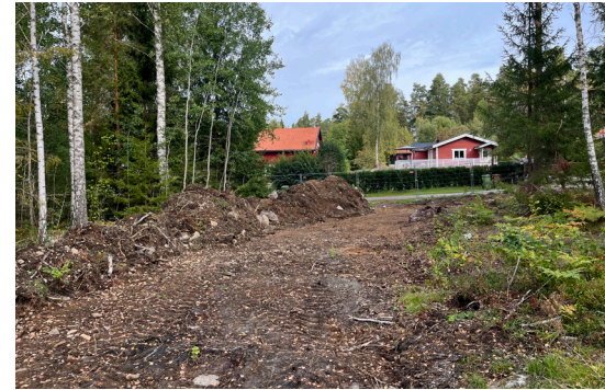
Bild från platsbesök, schakt för GC-väg genom naturmark.
