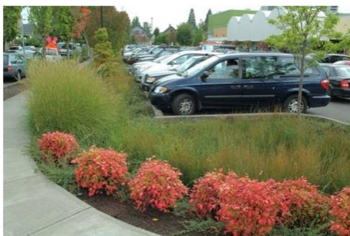
Figur 19. Exempel på nedsänkta växtbäddar på kvartersmark (Bildkällor uppe t.v. till nere t.h.: Nacka kommun, Stockholm Vatten och Avfall samt WRS).
