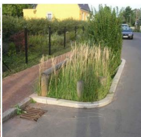
Figur 19. Exempel på nedsänkta växtbäddar på kvartersmark (Bildkällor uppe t.v. till nere t.h.: Nacka kommun, Stockholm Vatten och Avfall samt WRS).
