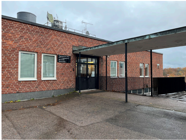
Entré mot hus B
