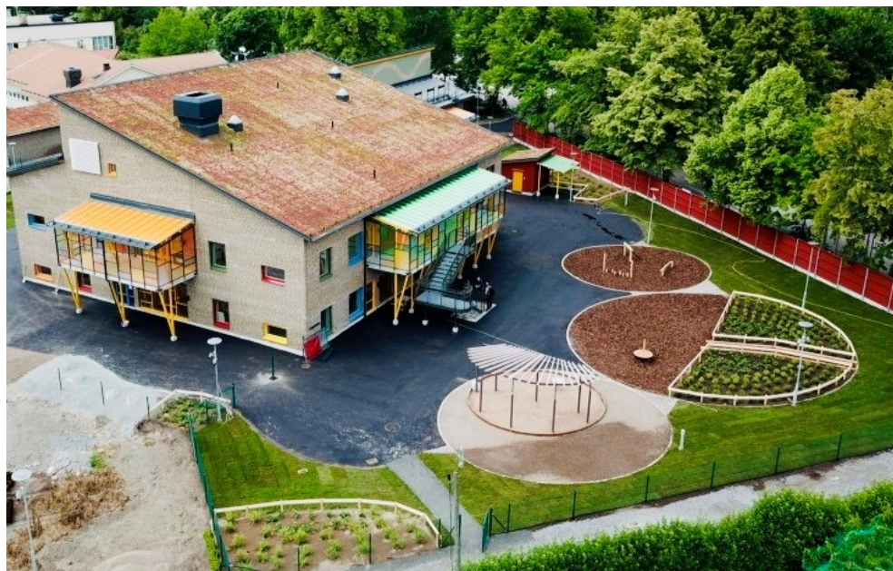
Grillby förskola. Typförskola byggd 2021.
